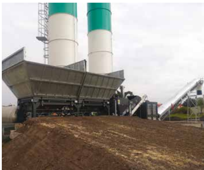
12. Vista complessiva dell'impianto
