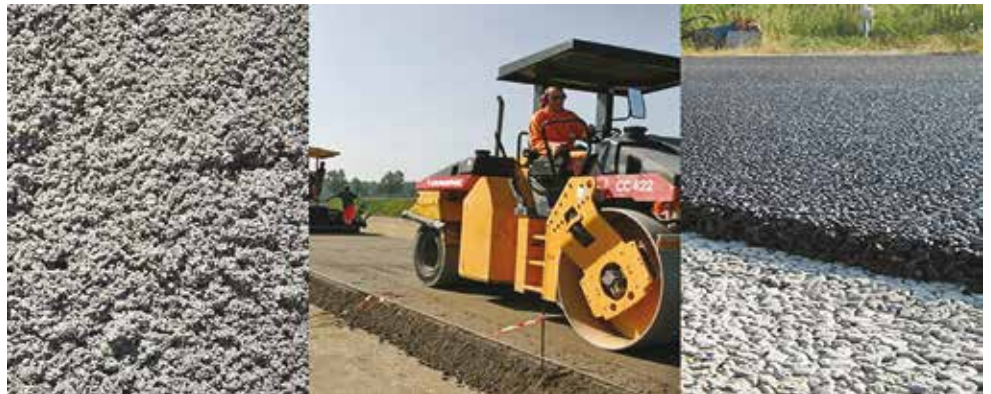
2. Alcuni dei prodotti realizzabili: calcestruzzo strutturale, misto cementato e fresato a freddo
