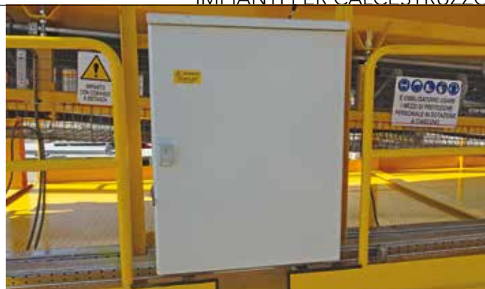
4. Tutte le carpenterie a bordo sono lucchettabili e fornite di pannelli ciechi per evitare danni da atti vandalici con resistenza IK10 e protezione IP65
