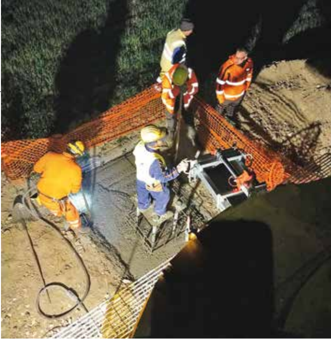
10. I primi getti di calcestruzzo durante le fasi di collaudo
