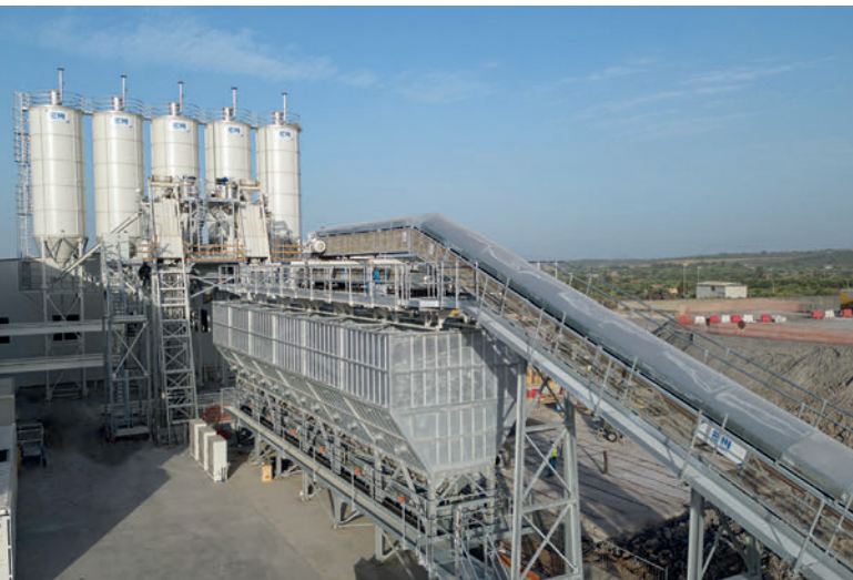
Montage d'une centrale à béton
